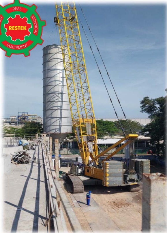
Gia công - Lắp đặt Silo
