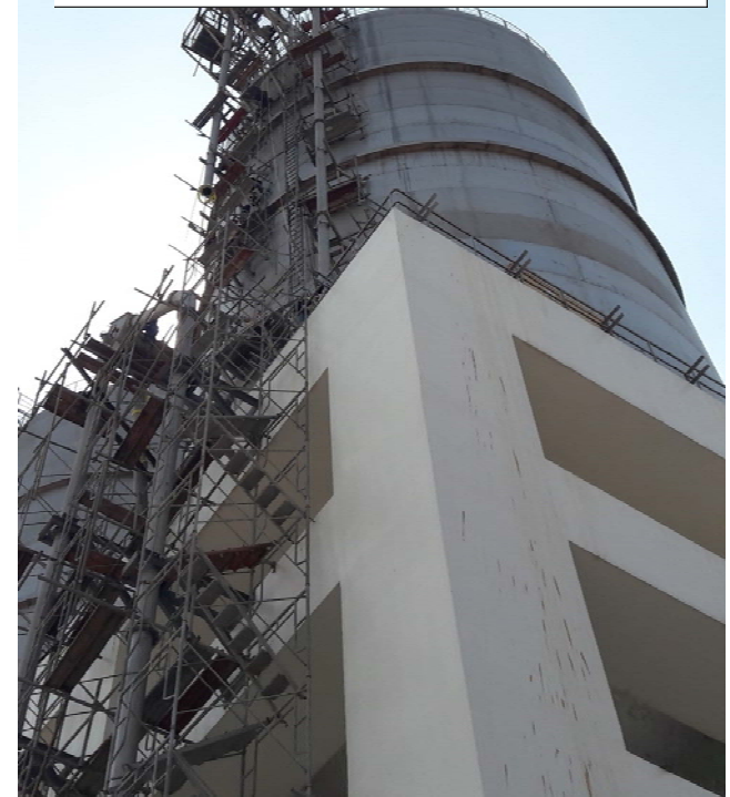
Lắp đặt ống xích tải liệu
